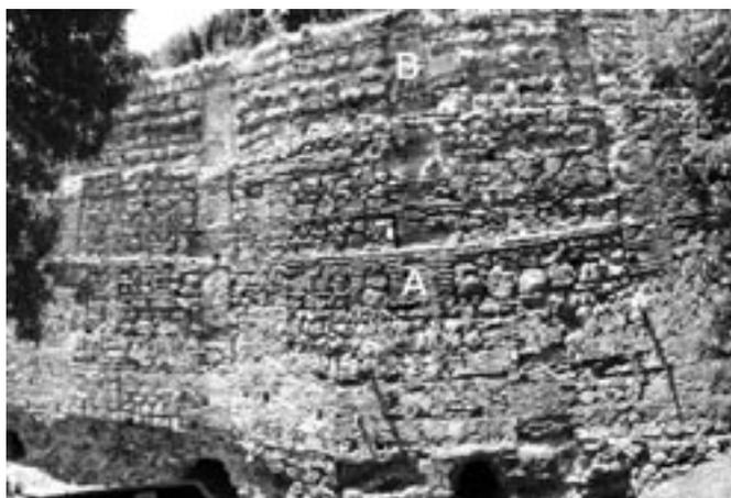
Fig. 4- Sector de la muralla (F2) que se encuentra en buen estado de conservación (s.XIII). En esta zona se identifican principalmente ladrillos del tipo II (A), aunque en la parte superior se reconoce el añadido de los ladrillos de tipo III (B) puestos en obra durante la fase de elevación en altura de la muralla (s.XIV).
