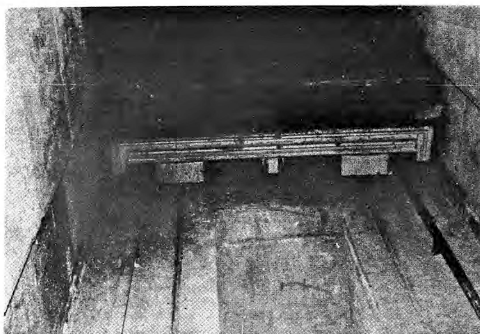
Vagoneta realizada en hormigón refractario de cemento aluminoso, en el interior de un horno túnel, construido asimismo en hormigón refractario.
