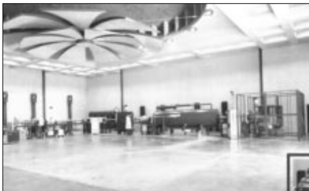
Aspecto general de la sala donde se encuentra el acelerador instalado en el CNA
