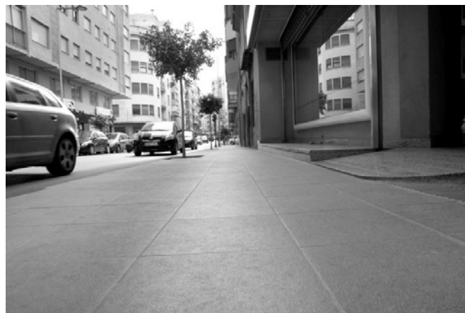
Figura 4. Pavimento Civis Agora instalado en acera.
